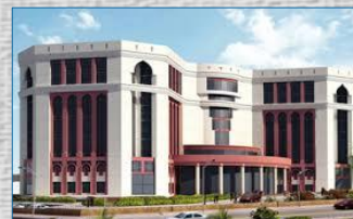
ASFOUR HOSPITAL ( F.C.U)
