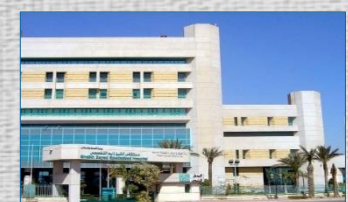
ZAYED HOSPITAL ( A.H.U / CU)
