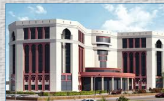
ASFOUR HOSPITAL ( F.C.U)
